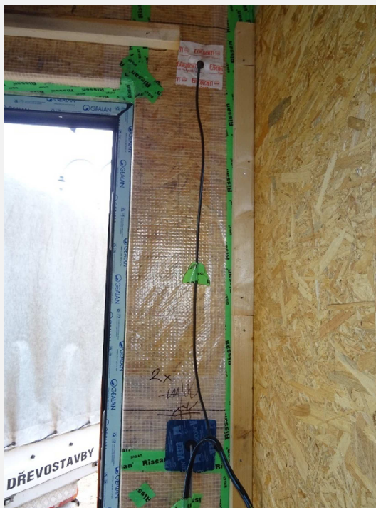
Prostupy elektroinstalace skrz parotěsnou folii
