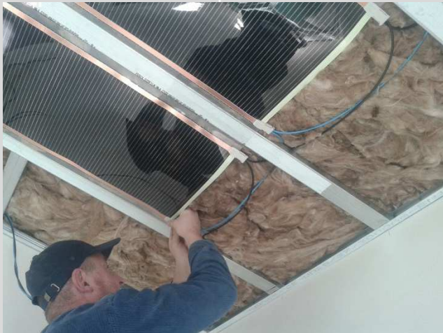
Instalace infravytápění (topná uhlíková folie) do podhledu
