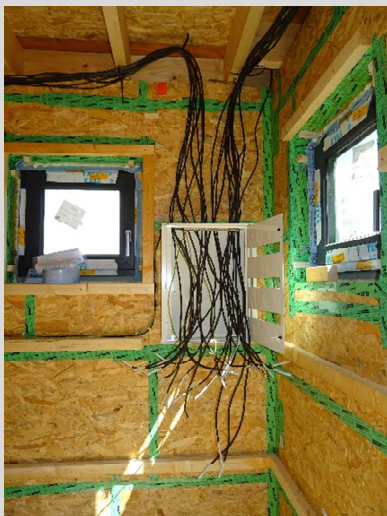
Provádění elektroinstalace, příprava na bytový rozvaděč
