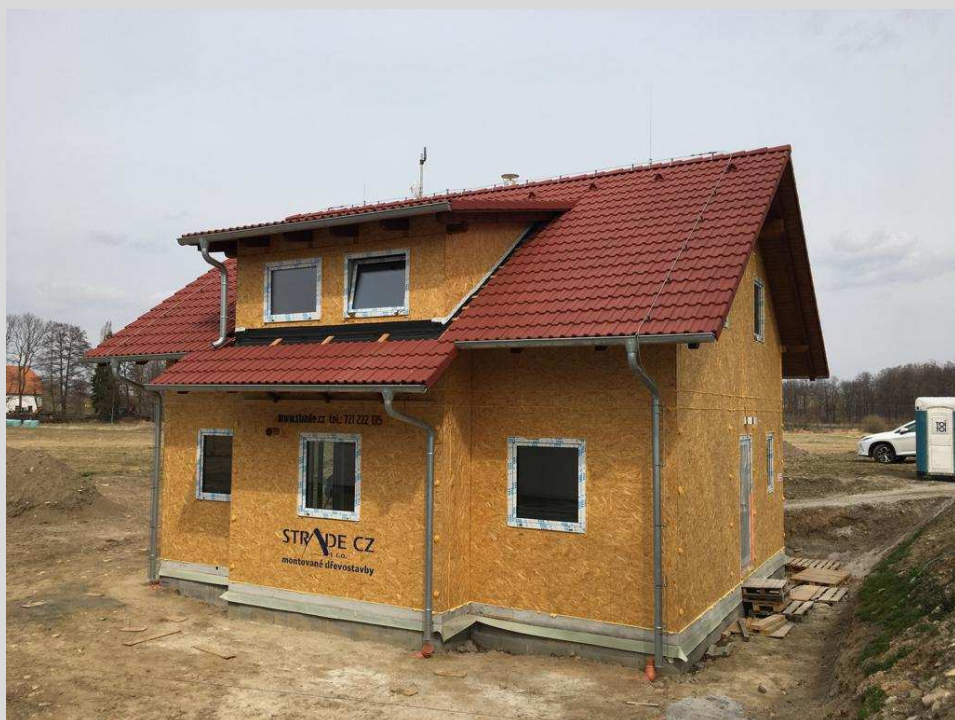
Realizace RD Adéla Vitějovice – hrubá stavba (2021)
